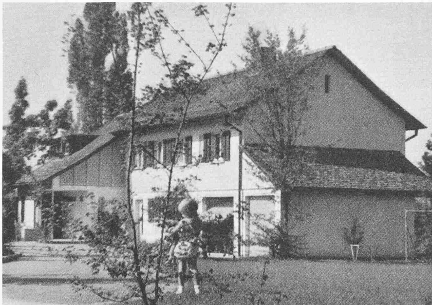
Bild 3. Ansicht aus Norden
