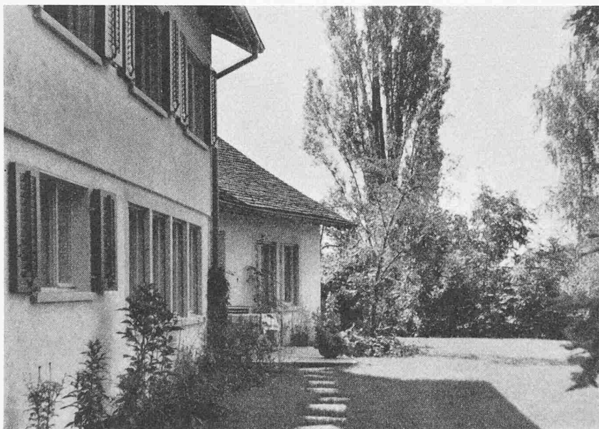
Bild 4. Ansicht aus Nordwesten
