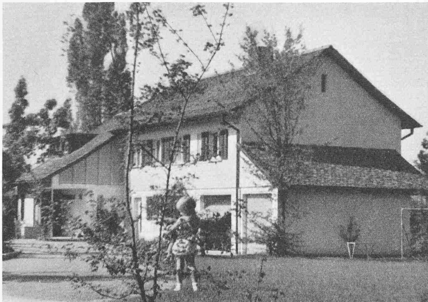
Bild 3. Ansicht aus Norden
