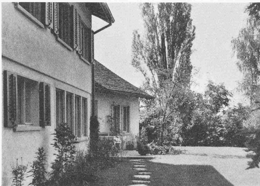
Bild 4. Ansicht aus Nordwesten
