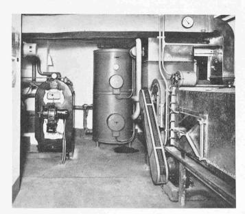
Bild 9. Heizraum mit Klimaapparaten rechts und Heizkessel links
