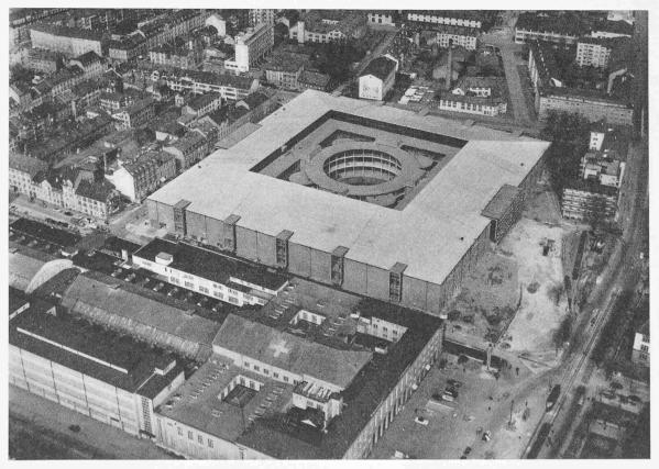
Bild 1. Fliegerbild aus Südwesten. Der Neubau von 400 000 m³ bietet 50 000 m² Bodenfläche, wovon 20 000 m² Ausstellungsfläche und 30 000 m² Verkehrsflächen und Nebenraumfläche. Totale Baukosten 16 Mio Franken
