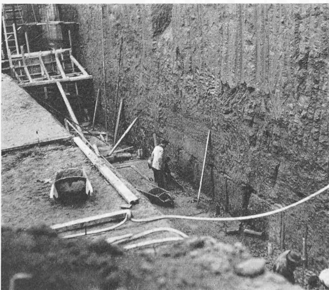
Bild 7. Schlierwand in der Wehrbaugrube
