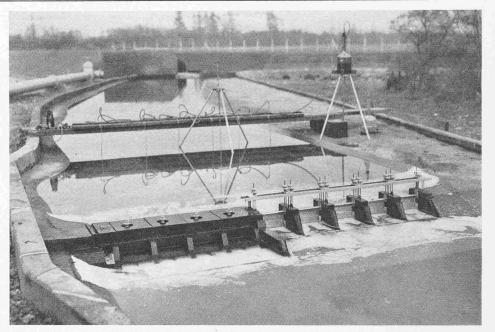
Bild 8. Flächenmodell 1:100 von Wehr und Krafthaus im Versuchsfreigelände
