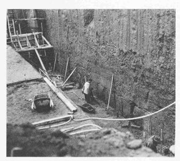
Bild 7. Schlierwand in der Wehrbaugrube
