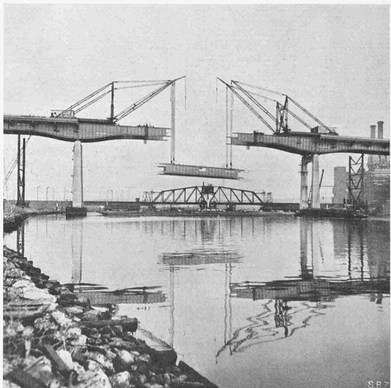
Bilder 2 und 3. Montage der Hauptträger der Passaic River-Brücke, 1951. Weite der Mittelöffnung 112 m
