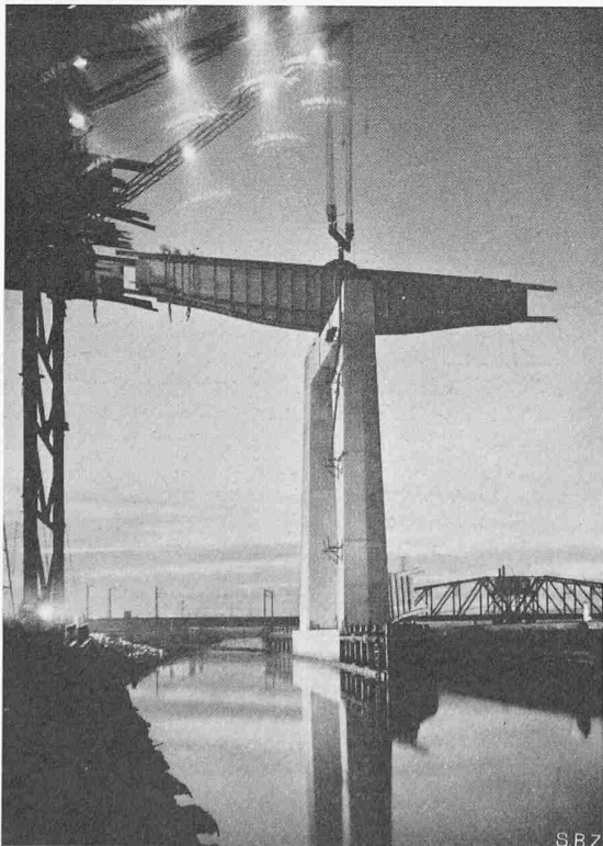
Bilder 2 und 3. Montage der Hauptträger der Passaic River-Brücke, 1951. Weite der Mittelöffnung 112 m
