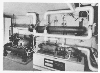
Bild 5. Kaltwasserpumpe, darüber Kaltwasserkühler, links Kältemaschine,
