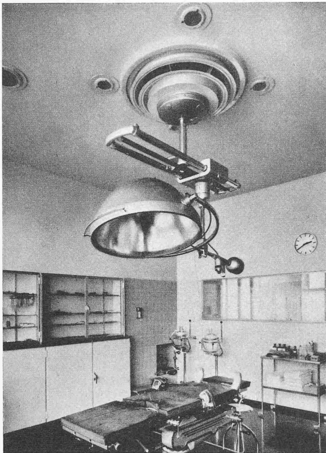
Bild 6. Operationslampe, darüber Zuluftzuführung.
