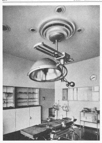
Bild 6. Operationslampe, darüber Zulufteinführung.
