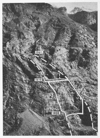
Bild 2. Rechte Flanke des Staumauerfundamentes, am Fusse des Mont Pleureur. Zone der Grossprengung in der untern Bildhälfte. Die Streiflöcher der Versuchssprengung sind sichtbar.
