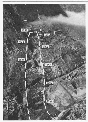
Bild 1. Linke Flanke. Stufenweiser Abbau des Fundamentes. Auf der oberen Bildhälfte von links nach rechts: Kabelkranwindenhaus, Beton-
