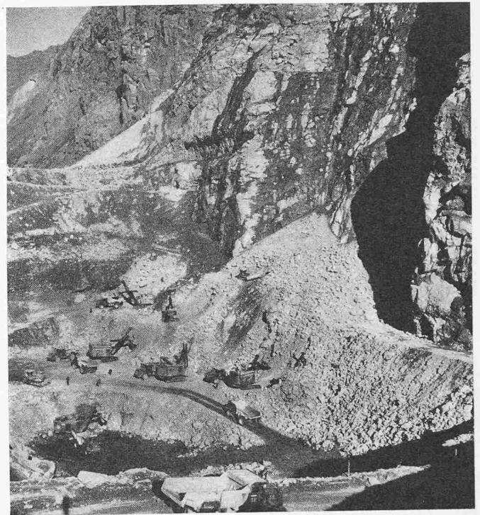
Bild 5. Baggerung des Sprengschuttes der Grosssprengung.
