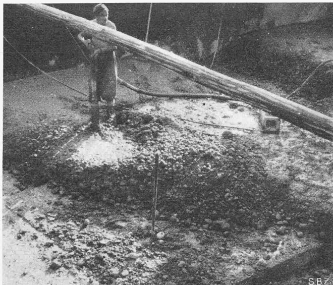
Bild 12. Abgerollte Grobteile infolge Entleerung des Betonkübels auf die alte Betonoberfläche
