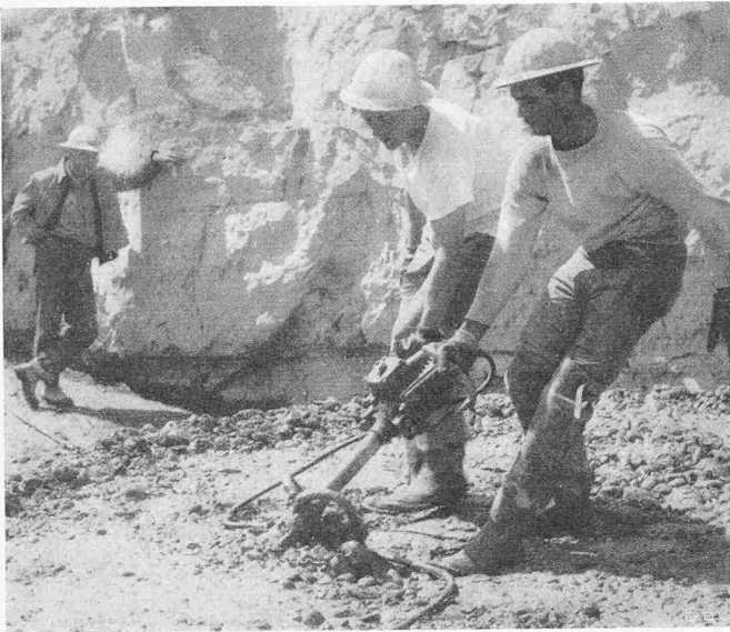
Bild 10. Das «Durchziehen» eines Rüttlers auf einer amerikanischen Baustelle
