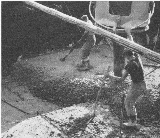
Bild 13. Entleerung des Betonkübels in die frische Mischung zur Vermeidung des Abrollens
