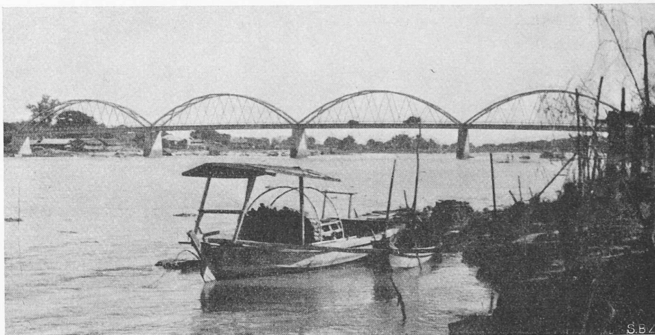
Bild 8. Die vier Flussöffnungen: versteifte Stabbogen mit dreieckförmig angeordneten Aufhängungen
