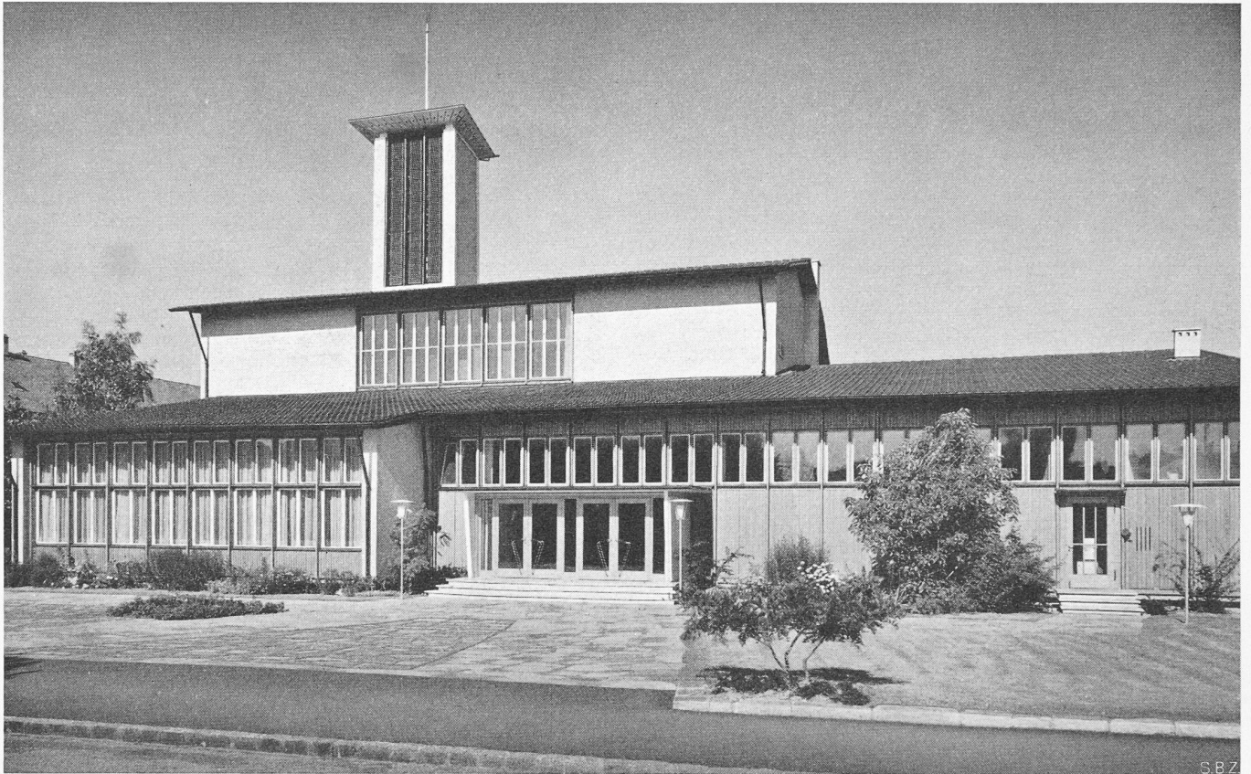
Bild 1. Die Eingangsseite an der Furkastrasse
