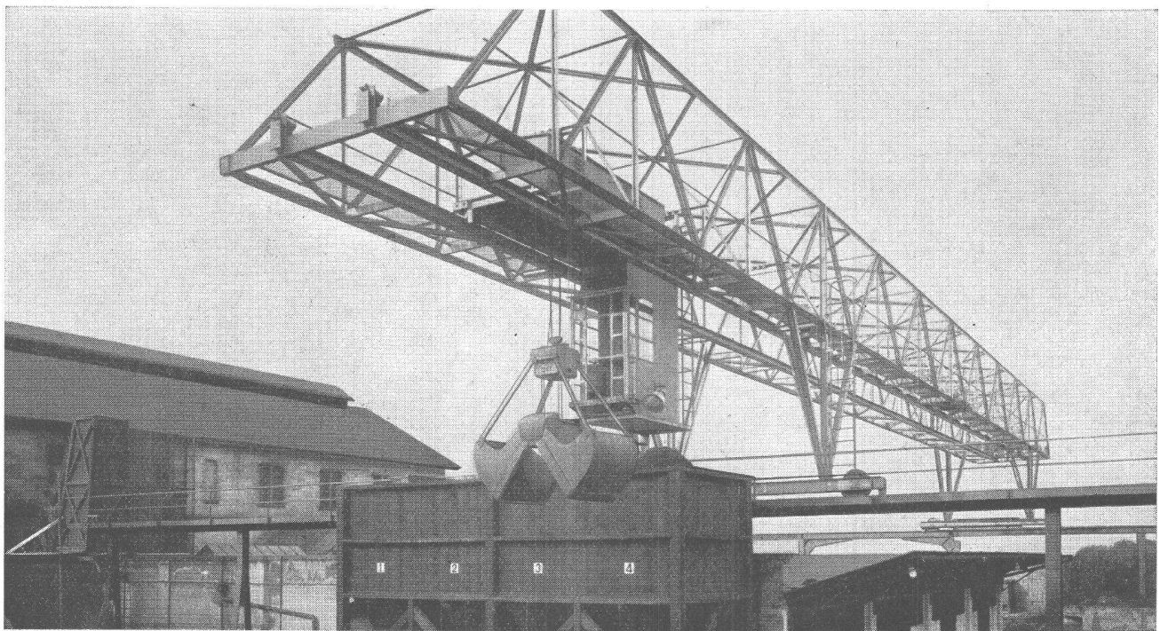
Verladebrücke in Schweisskonstruktion 2,5 t Tragkraft, 46 m Länge
