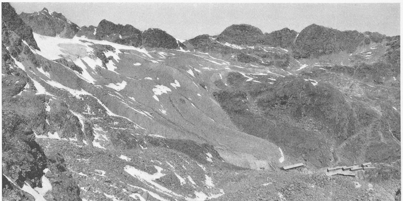
Bild 11. Stirnmoräne bei Parfleuri im Abbau, als Betonzuschlagstoff für die Gewichtstauwand Grande Dixence. Photo Grande Dixence S. A.
