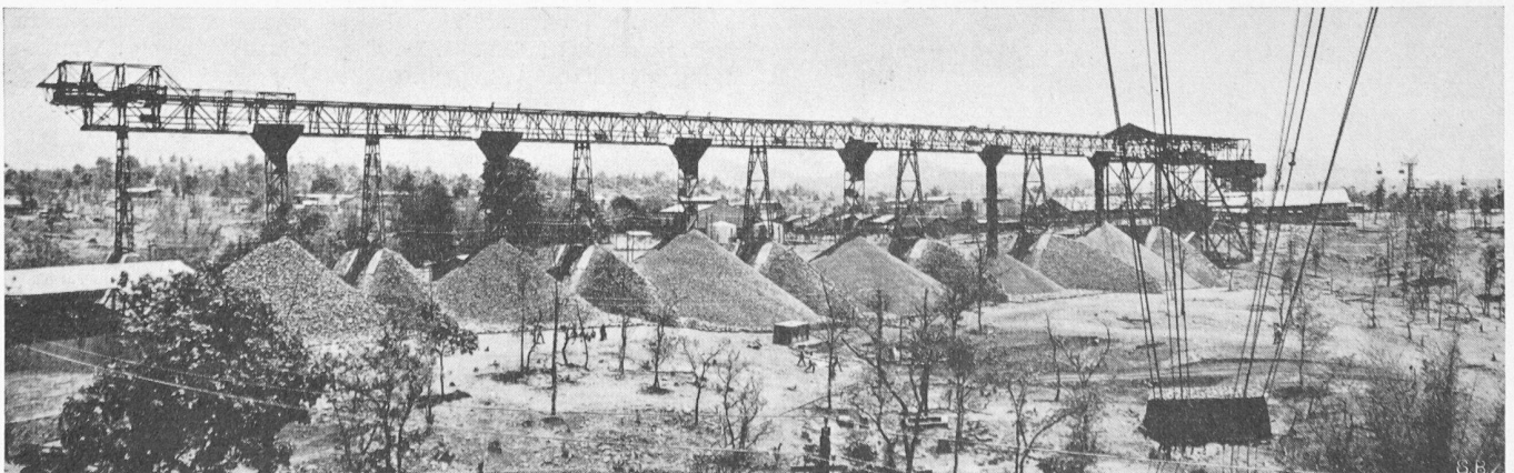
Bild 3 (unten). Materiallager für die sechs Komponenten, darüber Entladebrücke der Seilbahn, vom Fixpunkt des Kabelkrans aus gesehen.
