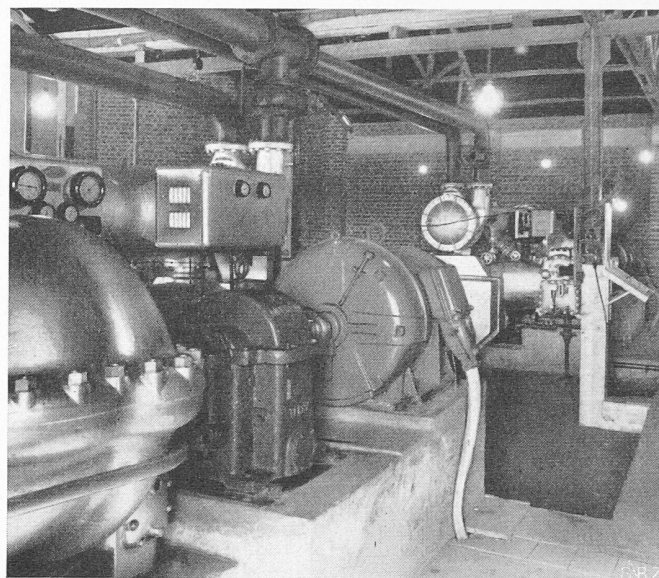
Bild 12. Inneres des Maschinenhauses mit zwei Carrier-Kältekompressoren.
