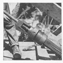
Bild 5 (rechts). Einbau des Felsankers: Ankerkopf m. Stellring, rechts Drahtbündel 40 Ø 5 mm, links Injektionsrohr.
