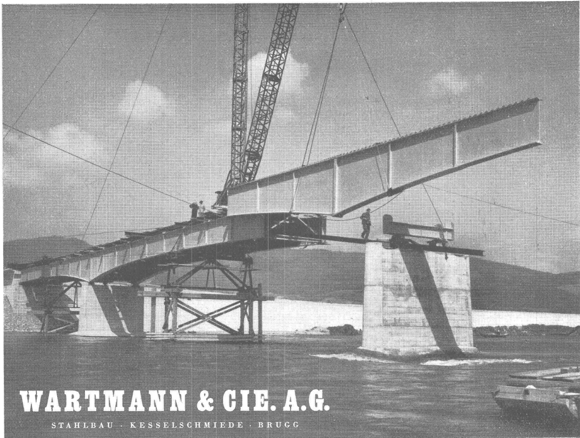
Montage der geschweissten Brücke über die Aare bei Schinznach-Bad (Mai 1952)
