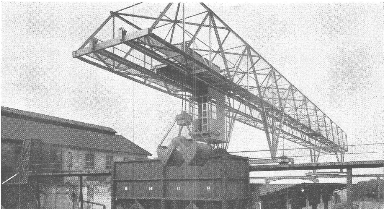
Verladebrücke in Schweisskonstruktion 2,5 t Tragkraft, 46 m Länge
