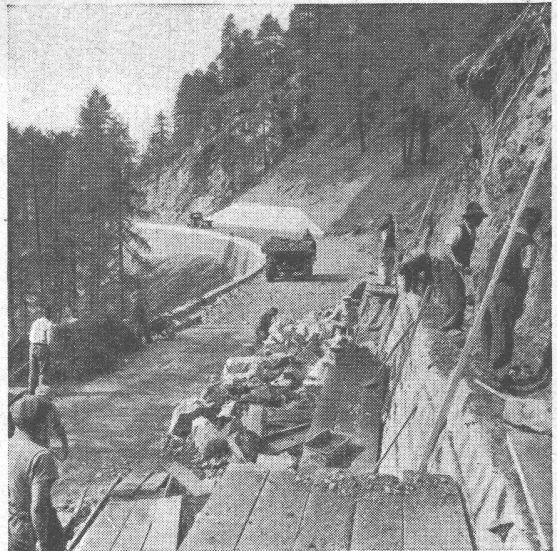
Neue Julierstrasse in Marmorera
