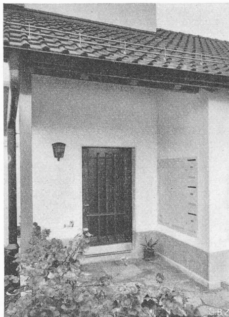
Bild 1. Hauseingangspartie, rechts neben der Haustüre die Kästen für Zähler und Schaltuhren; daneben die Brief- und Milchkasten.
