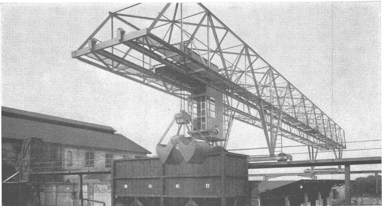
Verladebrücke in Schweisskonstruktion 2,5 t Tragkraft, 46 m Länge
