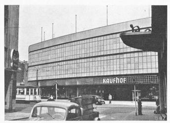
Bild 9. Modernstes Kaufhaus. Keine Oeffnungen nach aussen, Maximaler Lichteinfall. Klimaanlage regelt Temperatur und Feuchtigkeit der Luft im Innern
