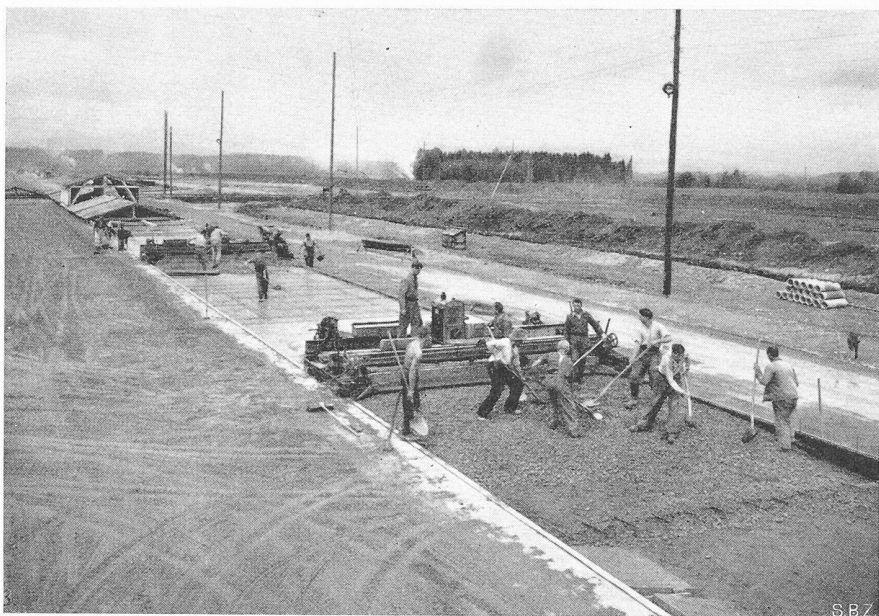
Bild 19. Betonieren der Betonbeläge auf der Westpiste. Im Vordergrund Einbau der unteren Betonschicht, dahinter verlegte Netzarmerung und Einbau der oberen Betonschicht
