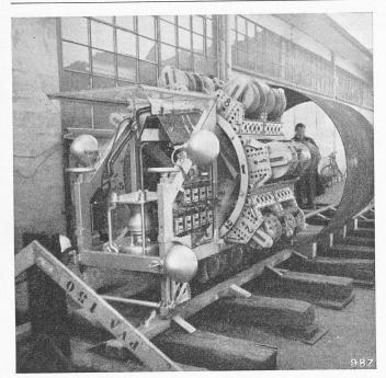
Bild 4. Neue von Arx-Rohrreinigungsmaschine bei Versuchen in Sissach an einem Rohr von 1,75 m Durchmesser
