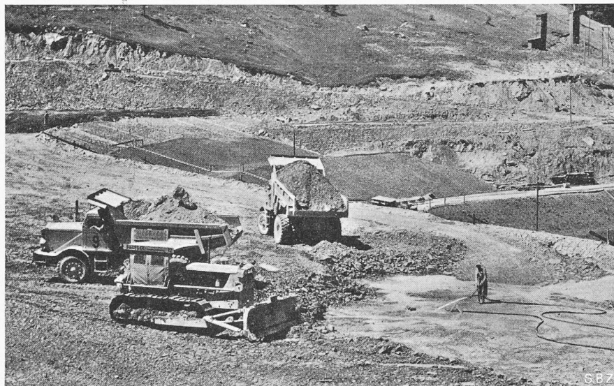
Bild 10. Aufbringen der Schüttung der Zone (3), Stützkörper.
