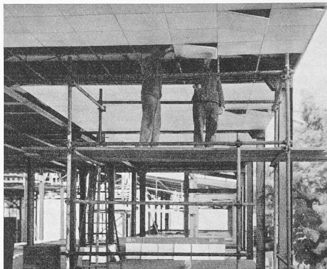
Bild 2. Montage der Deckenelemente im ALCOA-Building in Pittsburg, USA, wo insgesamt 22 500 m² Frenger-Decken montiert sind
