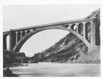
Bild 47. Isonzobrücke bei Salcano der Eisenbahnlinie Görz - Piedicolle, Spannweite 85 m
