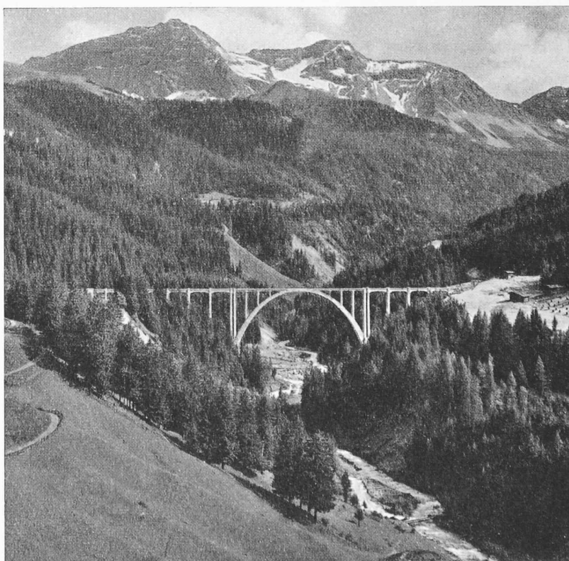
Bild 41. Langwieser Viadukt; Stützweite des grossen Bogens 100 m
