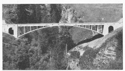
Bild 60. Strassenbrücke über das Val Tschiel bei Donath, Kt. Graubunden, 1925. Versteifter Stabbogen von 43,2 m Stützweite. Elegante technische Lösung mit selbstverständlicher organischer Gliederung des Tragwerkes von kühner, schönheitlich vollendeter Wirkung.
