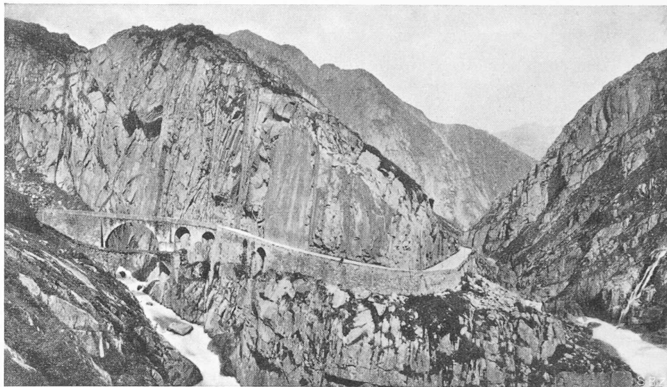
Bild 32. Strasse und Brücke von 1828, davor Brücke von 1595. Der Saumweg verlief offenbar nahe dem Fusse der jetzigen Stützmauer, teilweise auf natürlichem Felsband
