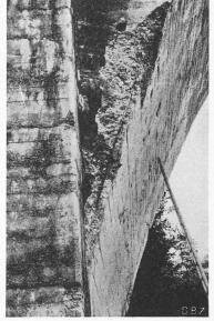
Bild 42. Betonschäden an der Hundwilertobelbrücke
