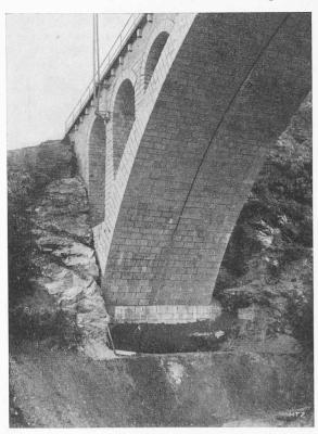
Bild 49. Robasaccobrücke der Cenerilinie der SBB; einheitliche Granit-Untersicht
