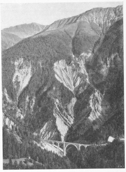
Bild 61. Wiesener-Viadukt der Rhätischen Bahn, 1906/09, lichte Weite 55 m. Steinviadukt in aufgelöster Bauweise (Quadermauerwerk), einem Filigrangebilde gleich von Menschengeist und Menschenhand in die Bergwelt kontrastrierend eingefügt
