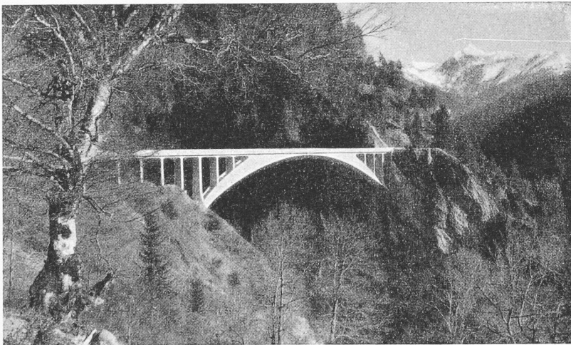
Bild 59. Strassenbrücke über das Salgina-Tobel, Kt. Graubünden, 1930, Stützweite 90 m. Schlicht, klar und zielbewusst, den Charakter der gegenwärtigen Bauweise in Eisenbeton zum Ausdruck bringend.
