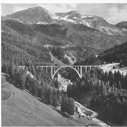
Bild 41. Langwieser Viadukt; Stützweite des grossen Bogens 100 m
