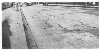
Bild 46. Lorrainebrücke in Bern, schadhafte Beton-Fahrbahn (Alter 25 Jahre)
