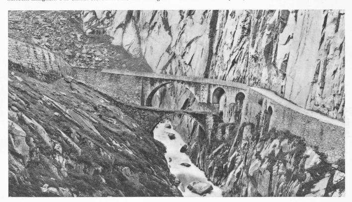
Bild 31. Die 1595 erbaute Teufelsbrücke, dahinter die heutige, 1828 mit 16,5 m Spannweite erbaute Strassenbrücke. Nach einer Photographie aus den 1860er Jahren
