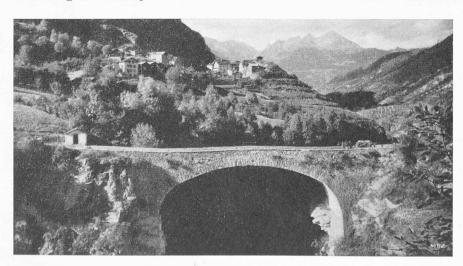
Bild 33. Kinnbrücke bei Stalden im Vispertal, erbaut um 1544. Spannweite rund 43 m, Bogen in zwei Ringen aus Bruchstein gemauert
