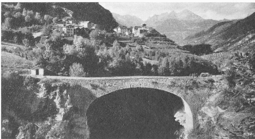
Bild 33. Kinnbrücke bei Stalden im Vispertal, erbaut um 1544. Spannweite rund 43 m, Bogen in zwei Ringen aus Bruchstein gemauert
