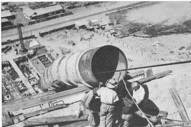
Bild 12. Druckleitungs montage
