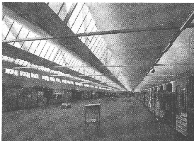
Shedbau für Lagerhalle
