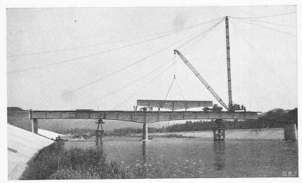
Bild 7. Montage, Antransport eines Trägers
