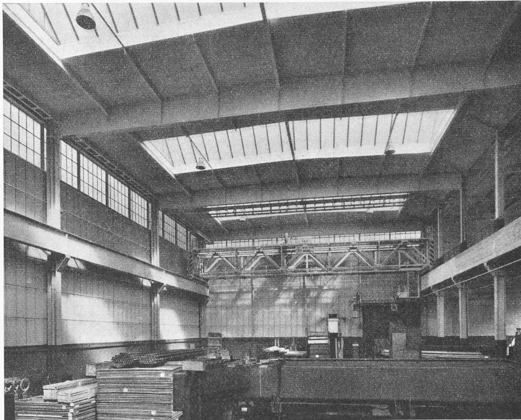
Bild 1. Blick in die Bearbeitungshalle; rechts Eisenbetonbrüstungsträger als Kranbahnträger
