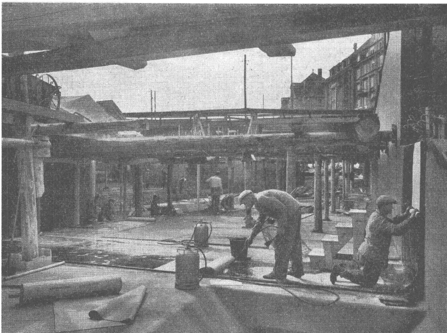
Unterführung Bahnhofquai Zürich, II. Etappe Grundwasser-Isolierung des Troges mit Bitumen- gewebeplatten ASPHALTOID
