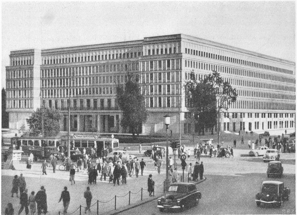
Bild 3. Gebäude der polnischen Arbeiterpartei in Warschau
