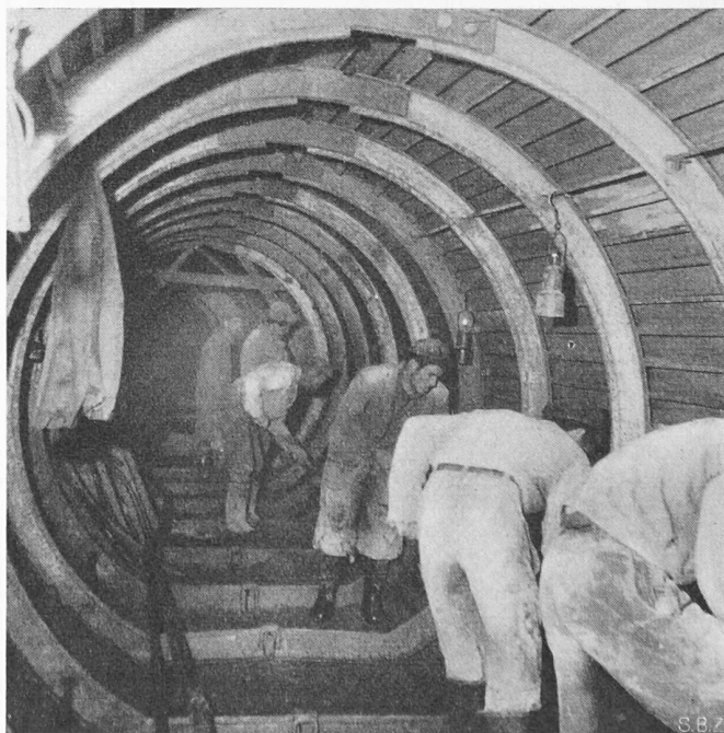
Bild 8. Leichtmetallschalungen für die Stollenbetonierung
