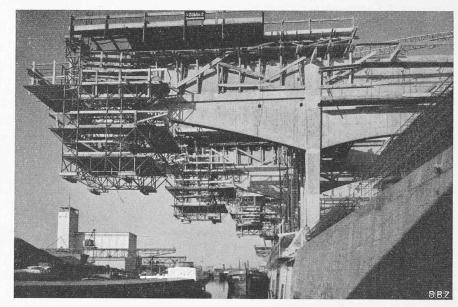
Bild 2. Die 32 m weit ausladenden Kranbahnkonsolen im Rheinhafen Kleinhüningen, im Bau nach System Dywidag. Photo Heman
