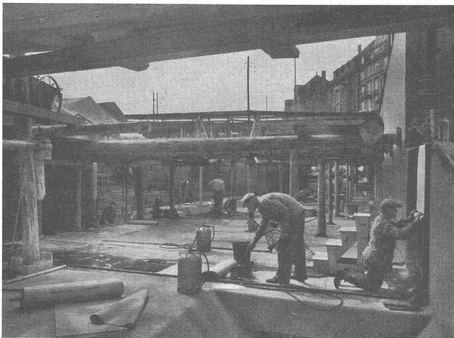
Unterführung Bahnhofquai Zürich, II. Etappe Grundwasser-Isolierung des Trogas mit Bitumen- gewebeplatten ASPHALTOID
