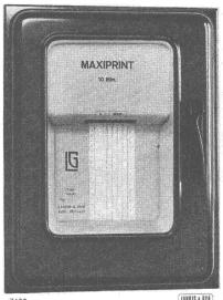
lichen Zählmechanismus, der bei der Rückstellung des Maximumzeigers die von diesem angezeigten Werte fortlaufend addiert, beim letztgenannten um einen Mittelwertdrucker, der in Verbindung mit einer Fern- oder Summenzähleinrichtung die Belastungsmittelwerte der einzelnen Registrierperioden auf einen Kontrollstreifen druckt.
