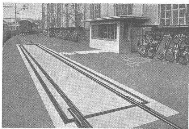
Die grösste Waage der Schweiz, eine Brückewaage für Geleise- und Strassenfahrzeuge mit einer Wiegefähigkeit von 150 000 kg. Ausgeführt in der bewährten Giroud-Konstruktion mit armierter Betonbrücke mit nur 4 Auflagepunkten und torsionsfreiem Hebelwerk in Stahl. Länge der Brücke 16,8 m.
