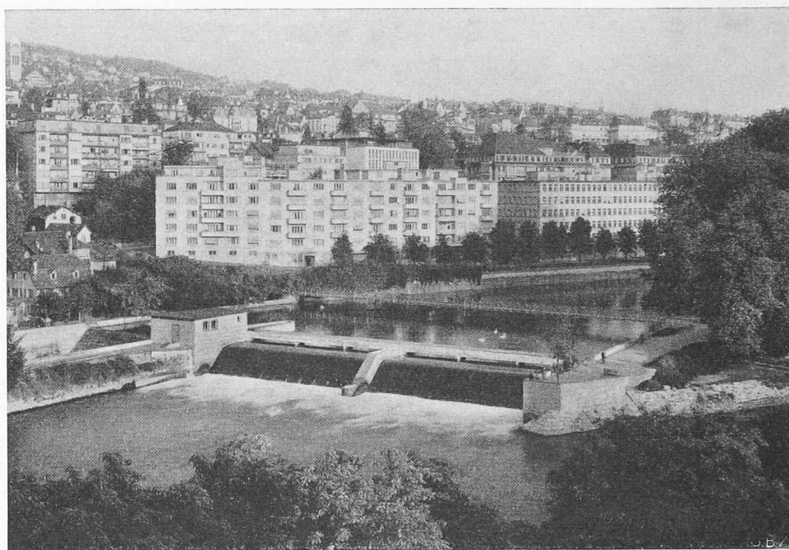
Bild 5. Hydraulische Dachwehnanlage beim Platzspitz
