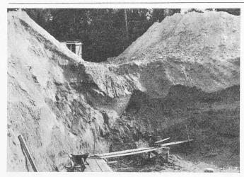
Bild 3. Die ganze Baugrube im feinen lehmigen Sand ist ausgehoben; nun beginnen die Wände auszubrechen, und es sollten, ohne jede sichernde Spriessung oder genügend abgeflachte Böschungen, die Fundamente und Aussenwände erstellt werden.
