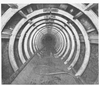
Bild 3. Montage der Murali an den fertig aufgestellten Spanten
