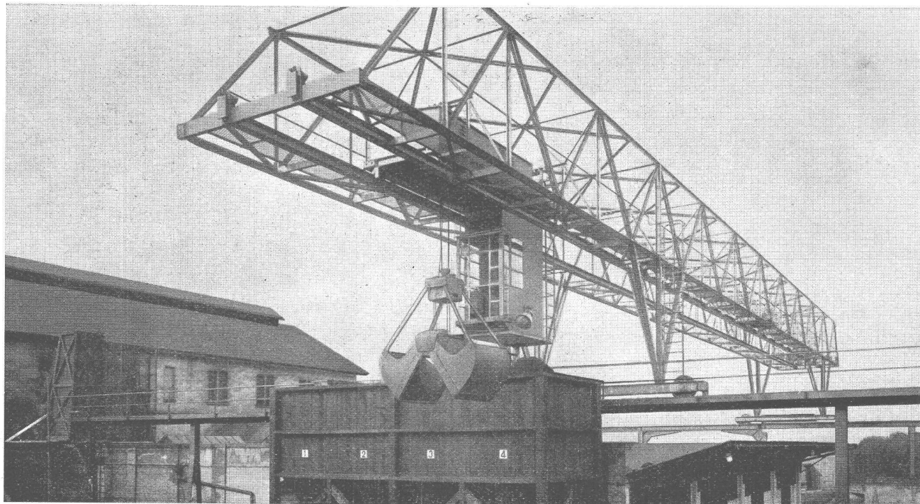
Verladebrücke in Schweisskonstruktion 2,5 t Tragkraft, 46 m Länge
