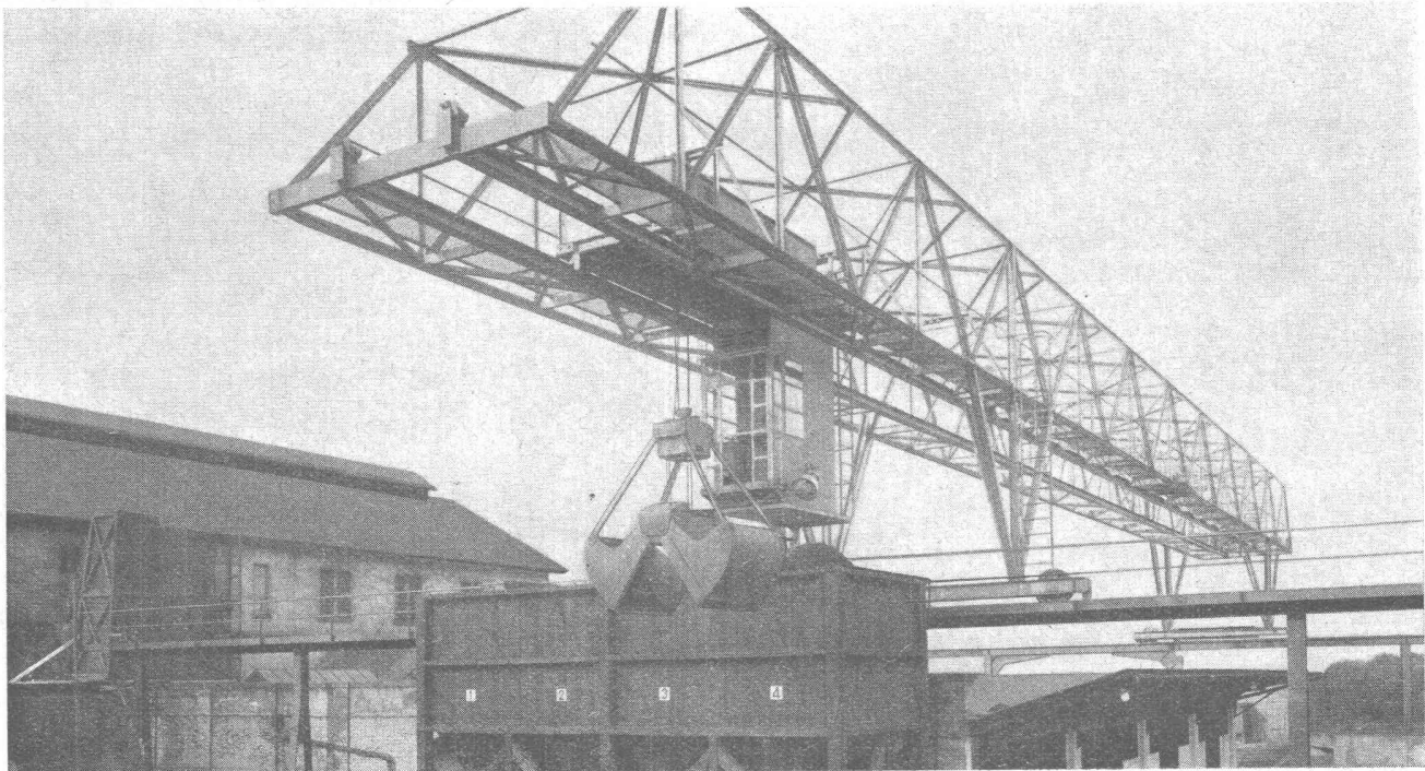
Verladebrücke in Schweisskonstruktion 2,5 t Tragkraft, 46 m Länge
