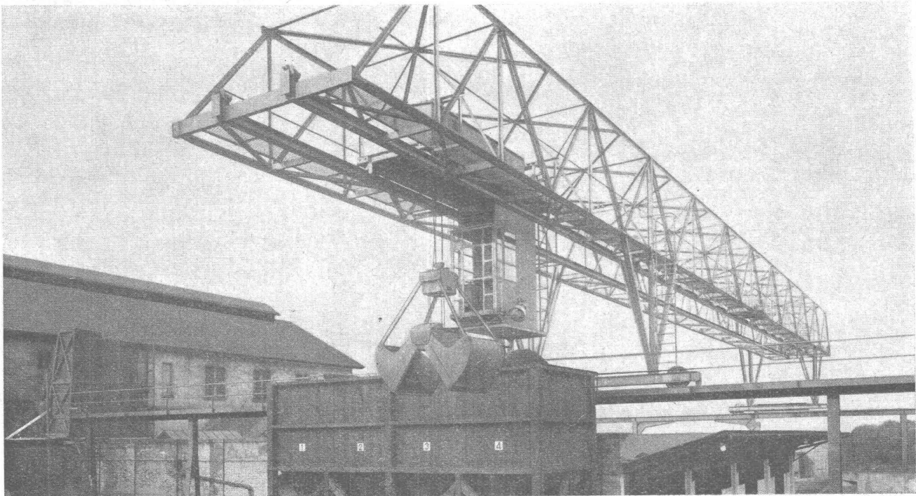
Verladebrücke in Schweisskonstruktion 2,5 t Tragkraft, 46 m Länge
