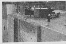
Bild 22. Nangal-Sperre. Verwendung vorfabrizierter Betonsteine zur Vermeidung von Holzschalungen. Man beachte den besonders geformten Betonstein auf der Oberseite des Pfeilers.
