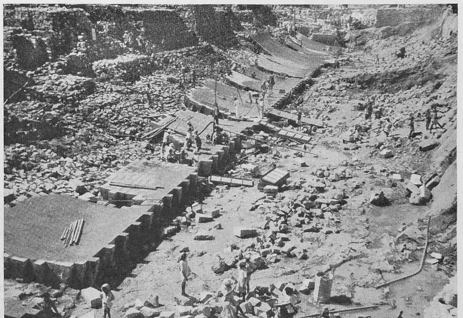
Bild 26 (links oben), Hirakud-Sperre, Abtransport des Aushubs, kleinere Ausbruchstücke durch Frauen auf dem Kopf (Vordergrund), grössere durch Männer mit Tragbalken (Mitte). — Bild 27 (links unten), Hirakud-Sperre. Sikh als Führer eines 10 m 3 Le Tourneau-Scrapers. Die Sikhs sind kenntlich am charakteristischen, die Ohren bedeckenden Turban und der Barttracht. Sie gehören einer Religion an, die eine Synthese zwischen Hinduismus und Mohammedanismus darstellt. In mancher Beziehung können die Sikhs als Elite gelten. Photos Ros. — Bild 28 (rechts), Tungabhadra-Sperre, Mauerwerk aus Granit, Blick auf die Ueberfallpartie, Ausführen der Granitverkleidung. Photo E. Gruner
