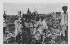
Bild 21. Nangal-Sperre, Betontransport: Auflad durch Männer, Transport durch Frauen vermittelst flacher, auf dem Kopf getragener Blechbecken. Die Frauen tragen meist Schleier.
