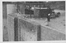
Bild 22. Nangal-Sperre. Verwendung vorfabrizierter Betonsteine zur Vermeidung im Bilde festgehal von Holzschalungen, Man beachte den besonders geformten Betonstein auf der Oberseite des Pfeilers.
