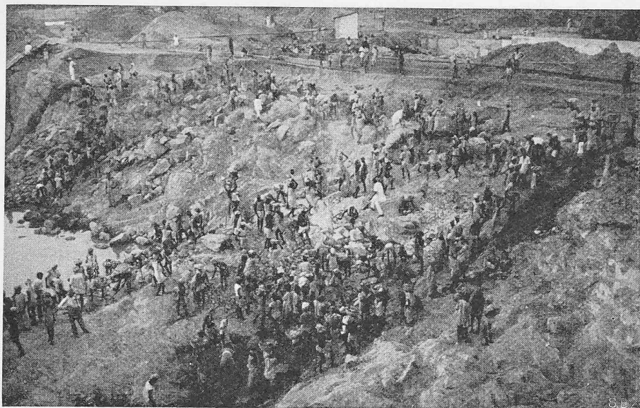
Bild 18. Fundamentausbruch für den Konar I-Damm der Damodartal-Behörde
