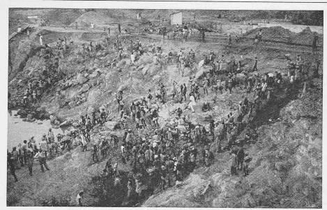
Bild 18. Fundamentausbruch für den Konar I-Damm der Damodartal-Behörde
