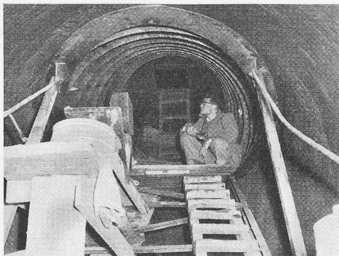
Fig. 8. Coffrage glissant vu par l'arrière
