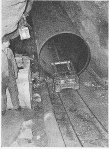
Fig. 5. Bétonnage d'une virole
