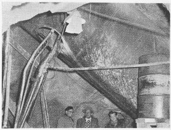
Fig. 4. Chambre d'injection à la cote 1040. Passage du blindage et trou d'homme
