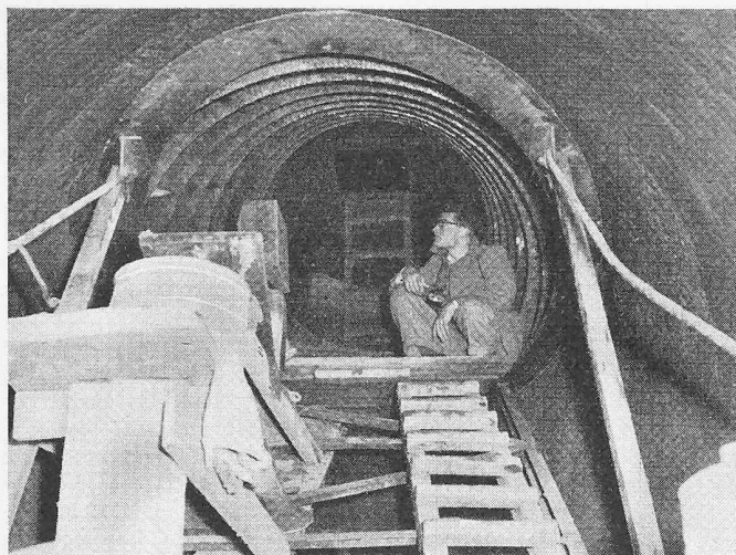
Fig. 8. Coffrage glissant vu par l'arrière
