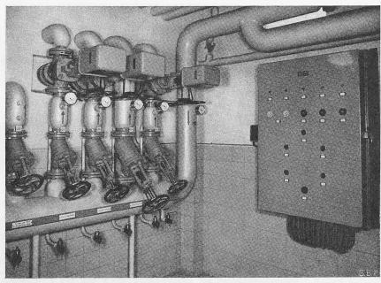
Bild 6. Der Reglerraum mit den automatischen Mischventilen und den Apparaten von Landis & Gyr
