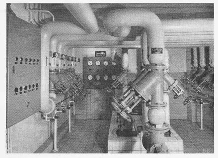
Bild 5. Reglerraum mit Apparate- und Steuertableau, in der Mitte die Pumpenanlage
