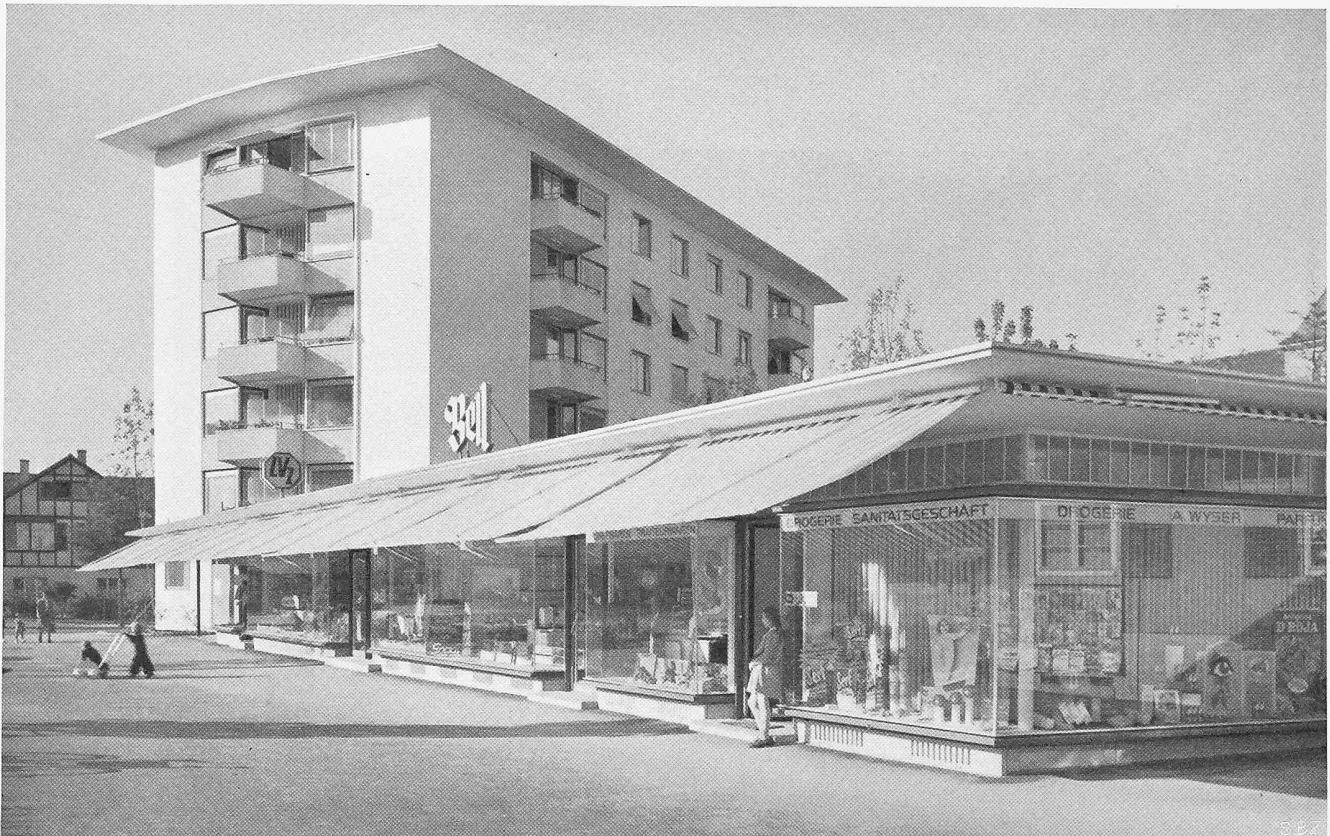
Ladenbau an der Gutstrasse aus Südosten, im Hintergrund der sechsgeschossige Wohnblock
