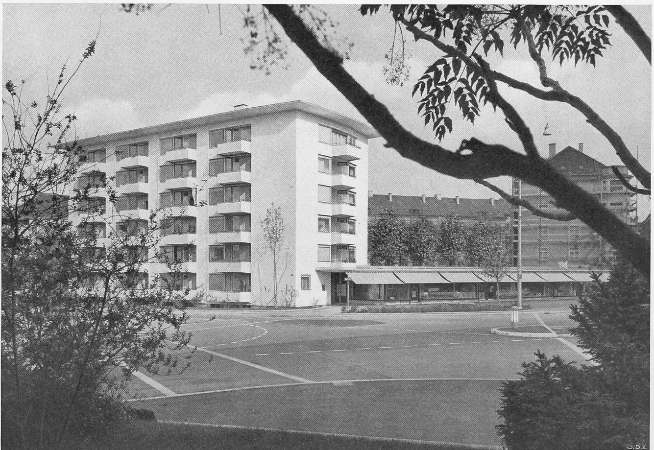
Wohnblock an der Bertastrasse aus Südwesten, im Hintergrund die alte Bebauung, davor Grünanlage im Innenhof
