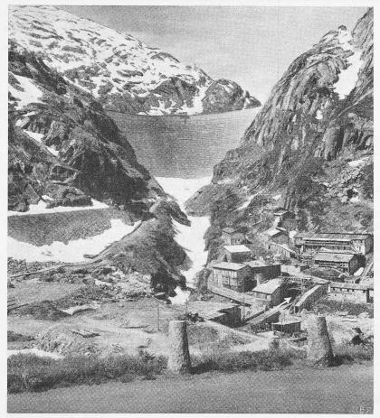
Bild 60. Die Baustelle im «Sommerloch», unterhalb der Spitallammsperre, am 12. Juni 1952. Der weisse Pfeil zeigt von der Zufahrtsbrücke zur Mündung des Hauptzuganges in die Zentrale Grimsel
