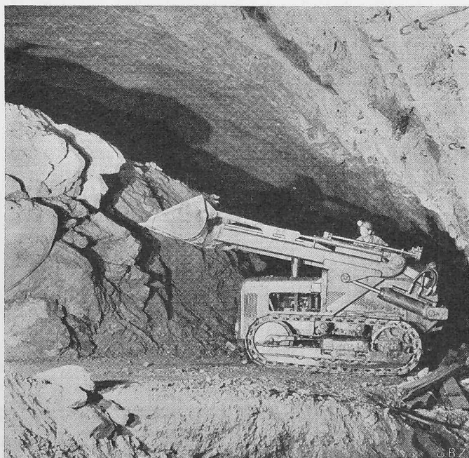
Bild 61. Ausbruch der Kalotte der Zentrale Grimsel, 29. Okt. 1950.
