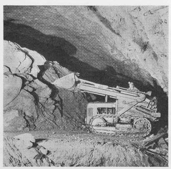
Bild 61. Ausbruch der Kalotte der Zentrale Grimsel, 29. Okt. 1950.
