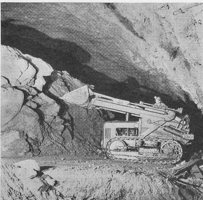
Bild 61. Ausbruch der Kalotte der Zentrale Grimsel, 29. Okt. 1950.
