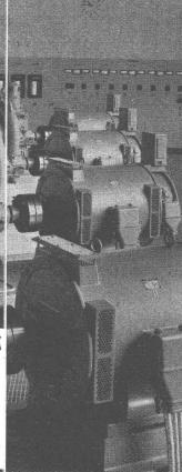
Pumpanlage Schönau, Bern 4 Oerlikon-Schleifringankermotoren 320 PS, gekuppelt mit Sulzer-Zentrifugalpumpen
