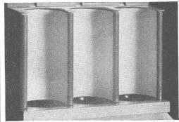
Deckplatte Fusschale Gusseisen Rundwand Stahlblech
