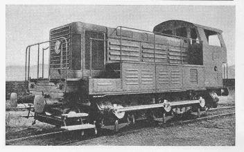
Bild 10. Diesel-elektrische Rangierlokomotive der SNCF, ausgerüstet mit einem Sechszylinder-Sulzer-Dieselmotor von 500 PS
