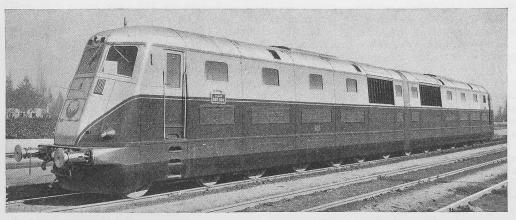
Bild 8. Diesel-elektrische Lokomotive von 4400 PS der Société Nationale des Chemins de Fer Français für die Förderung von 600 t schweren Zügen mit 80 km/h auf Steigungen bis zu 8 % bzw. mit 130 km/h in der Ebene (Lieferjahr 1938)
